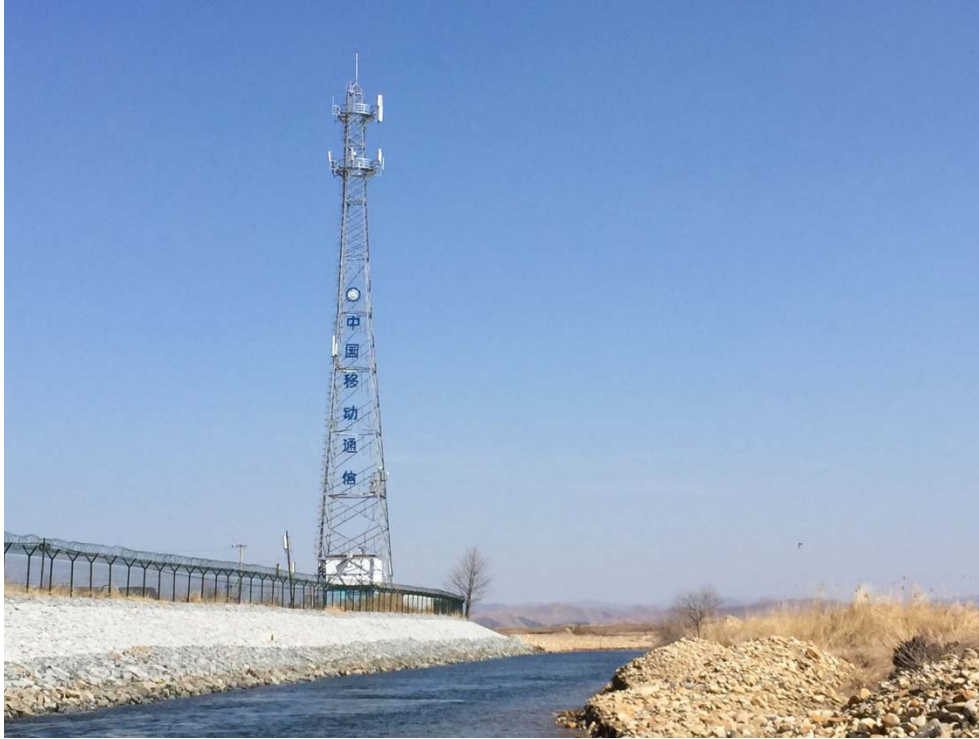
写真: 中国と北朝鮮の国境にある携帯電話用電波塔。フェンスの左側が中国、右側が北朝鮮。(出所: ソキール・バク、LiNK)。
